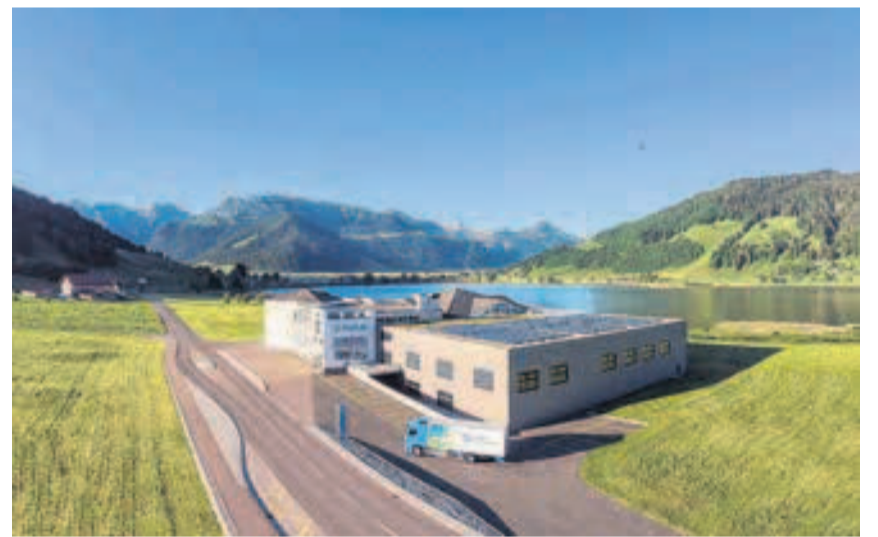
Die neue Fertigungshalle am Standort Euthal.
